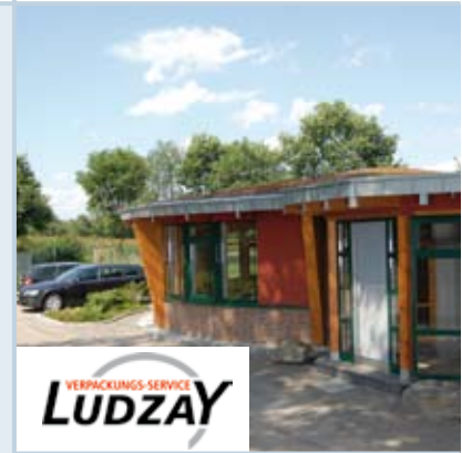
Bürogebäude D. Ludzay in Dorsten
